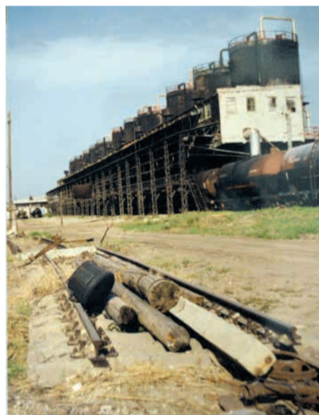
Битумная установка 90-х годов
