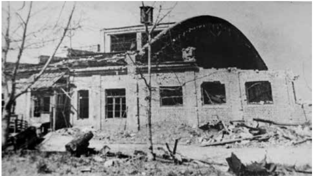
Разрушен ремонтно-механический цех
