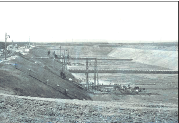
Строительство нефтехранилищ на 86 000 тонн
